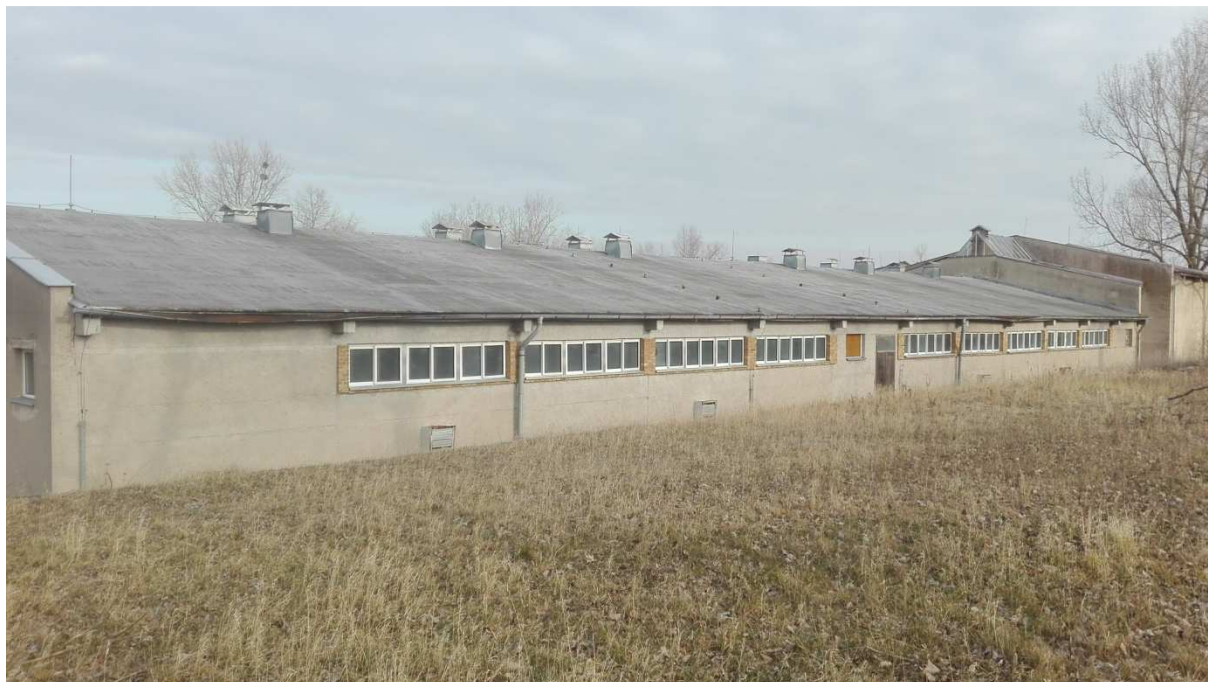
Stáj určená k modernizaci
